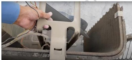
**Fig. 3.8 Pulling up the fan motor assembly**
