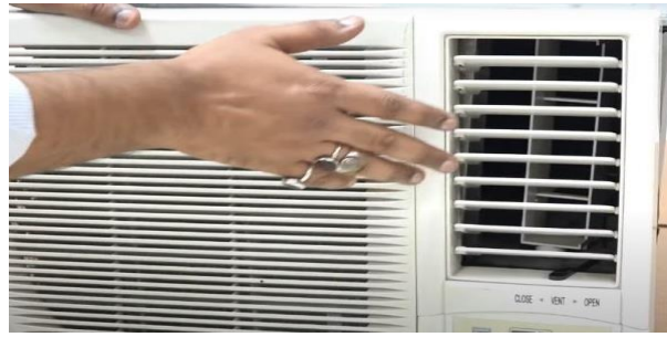
Fig. 1.12 Adjustable louvers
